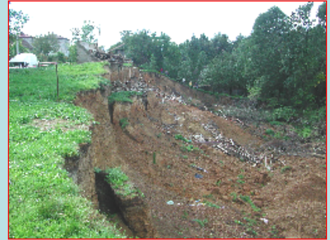
Widok na niszę osuwiska po zburzeniu najbardziej zagrożonych i zniszczonych budynków
