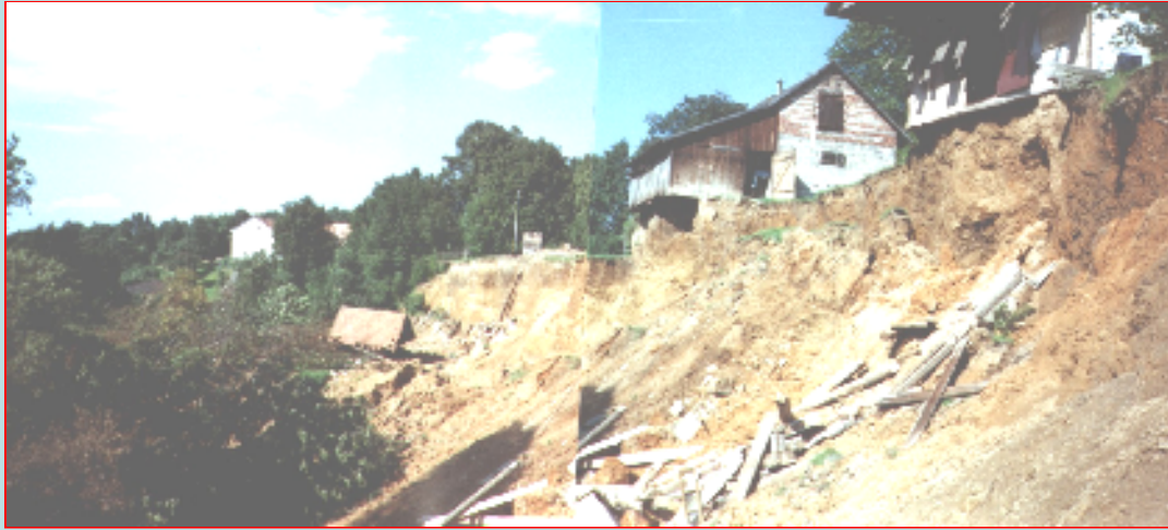
Zagrożone budynki przy ulicy Falkowskiej
