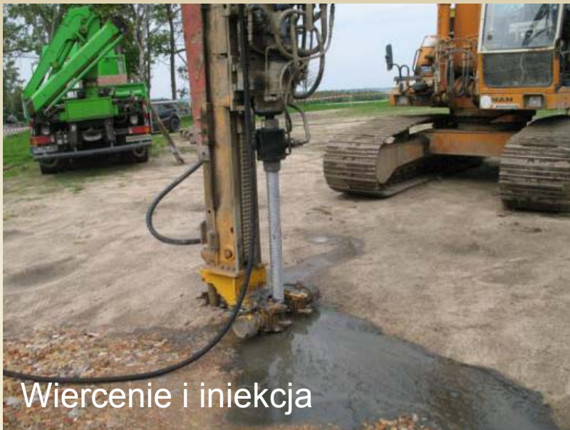
Przepłukiwanie i wypłukiwanie iniektu z wnętrza żerdzi
