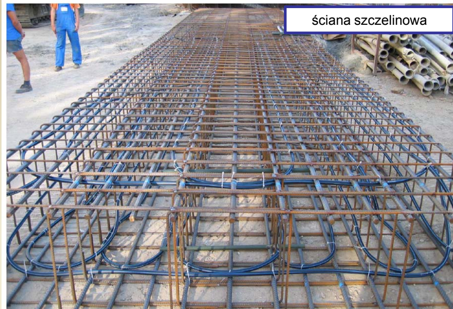
Instalacja termopala
