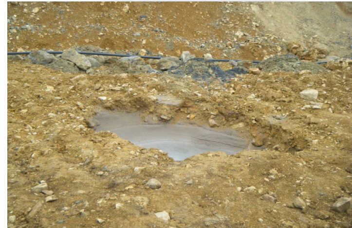
DEFORMACJA NIECIĄGŁA TYPU POWIERZCHNIOWEGO W POSTACI ZAPADLIKA O KSZTAŁCIE ELIPTYCZNYM
