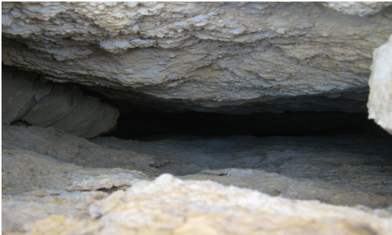
DEFORMACJA NIECIĄGŁA TYPU LINIOWEGO W POSTACI SZCELINY OTWARTEJ
