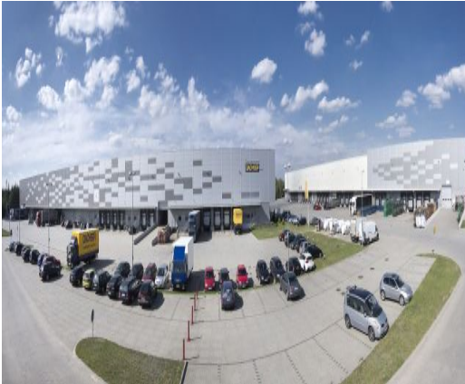
HALA LOGISTYCZNA SOSNOWIEC
