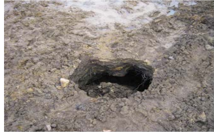
DEFORMACJA TYPU POWIERZCHNIOWEGO W POSTACI ZAPADLIKA O KSZTAŁCIE KOŁA
