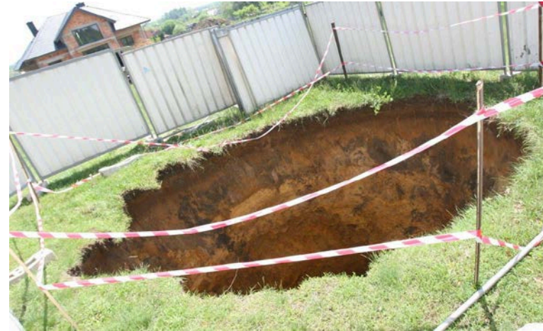
DEFORMACJA TYPU POWIERZCHNIOWEGO W POSTACI ZAPADLIKA O KSZTAŁCIE ELIPTYCZNYM
