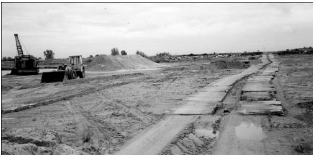
Rys. 4. Droga tymczasowa z płyt betonowych
