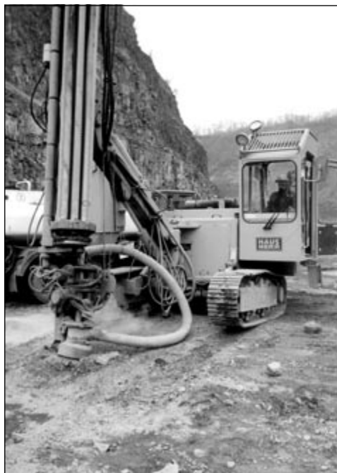
Rys. 28. Wiertnica w trakcie wiercenia otworu strzałowego
