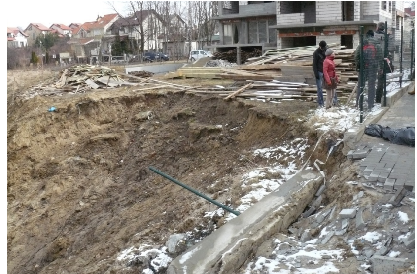
Osuwisko przy ulicy Ornej w Gdyni (fot. A. Małka)
