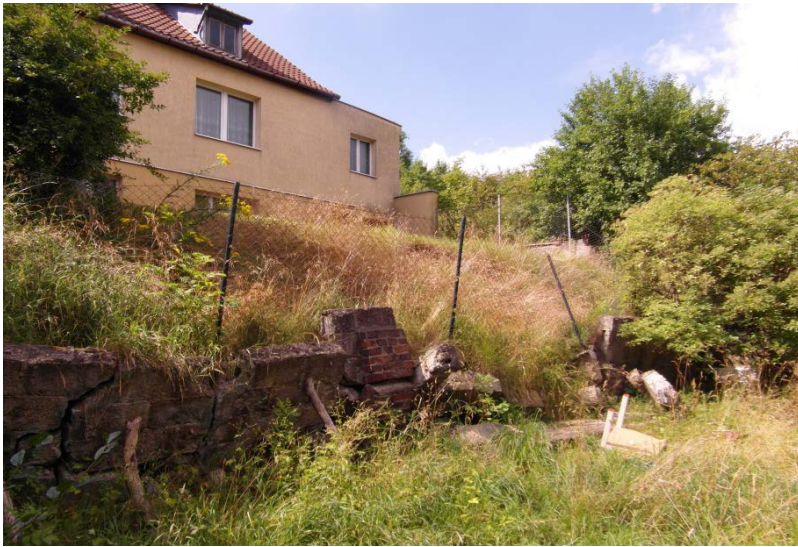
Osuwisko w północnej części dzielnicy Wzgórze Mickiewicza w Gdańsku (fot. T. Szarafin)
