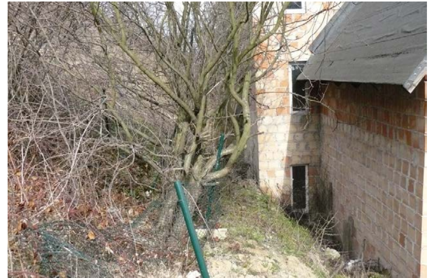
Osuwisko przy ulicy Dembińskiego w Gdyni, kolumium napierające na budynek mieszkalny (fot T. Szarafin)
