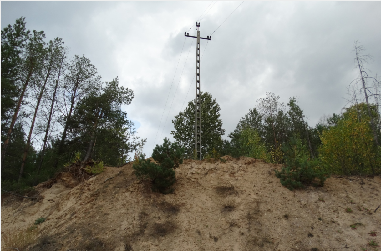
Zagrożona linia średniego napięcia na skraju niszki eksploatacyjnej w powiecie hajnowskim - widok z dna wyrobiska.
