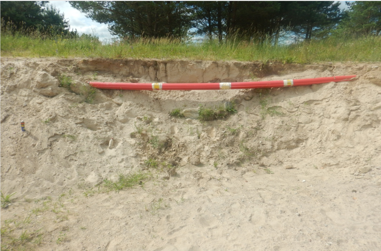
Odkopane i wtórnie zabezpieczone przewody poziomej linii 10 000 V na wyrobisku w powiecie giżyckim.
